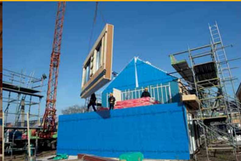
Bij houtskeletbouw komt de isolatie tussen de regels. Door te werken met een minerale wol die je overmaats snijdt, kun je deze eenvoudig kierdicht plaatsen.
